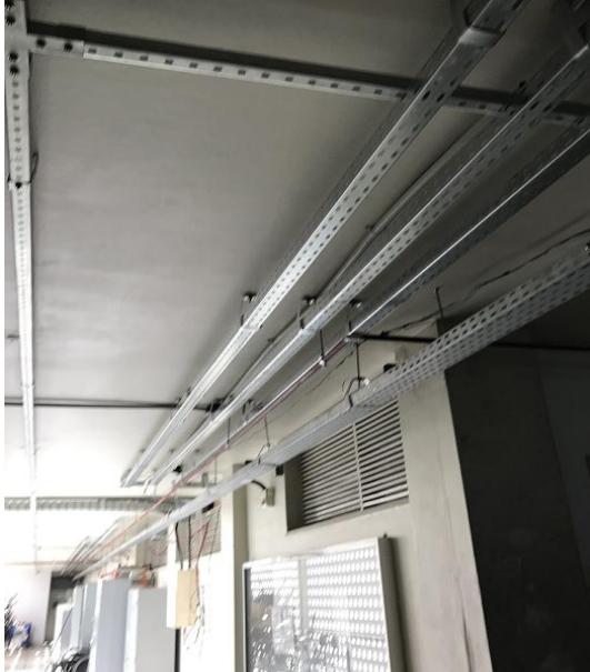
Figura 161: Circulação do 1º pavimento – Calhas elétricas novas e adequações a rede de gás G.L.P
