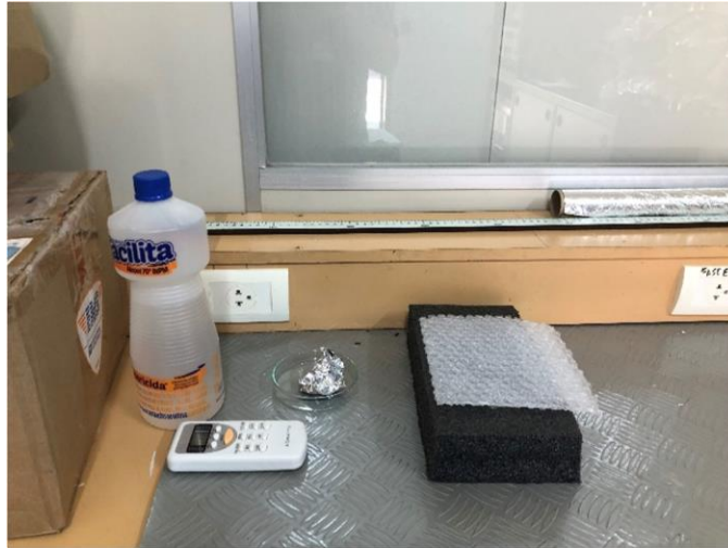
Figura 104: Tomadas antigas encontrada no Lab. de Oficina Eletrônica que não estão em conformidade com NBR-14136
