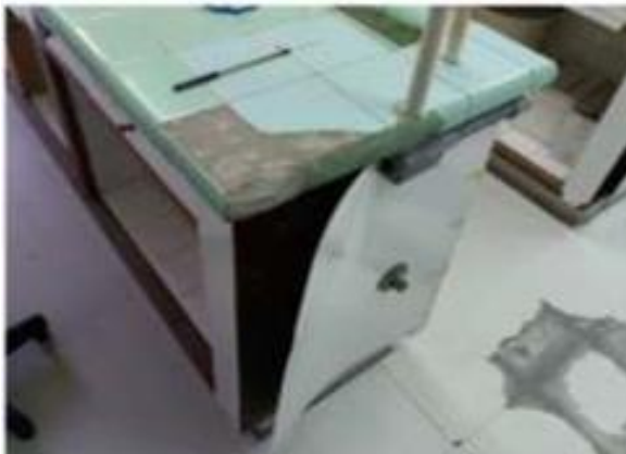
Figura 163: Interior do Laboratório de Microbiologia Clínica antes da reforma
