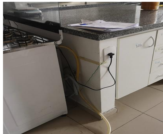
Figura 155: Pontos de Gás G.L.P na alvenaria; e Figura 156: Fogão com mangueira de borracha, sem a presença do botijão P13, no momento da visita técnica.
