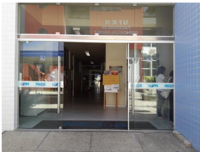
Figura 144 : Acesso principal do Bloco I
