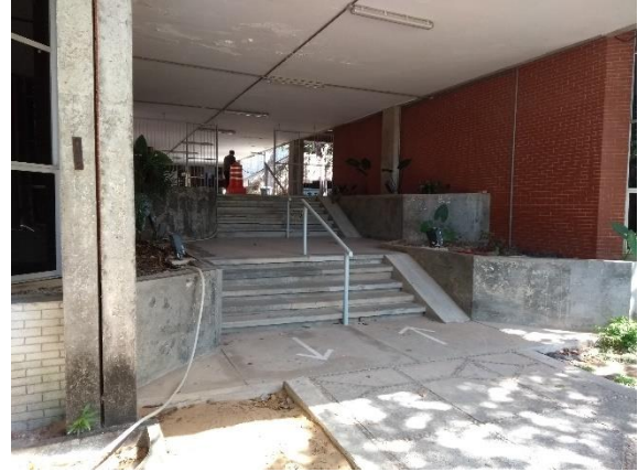
Figura 124: Acesso principal do CB a partir do estacionamento da Rua das Biociências
