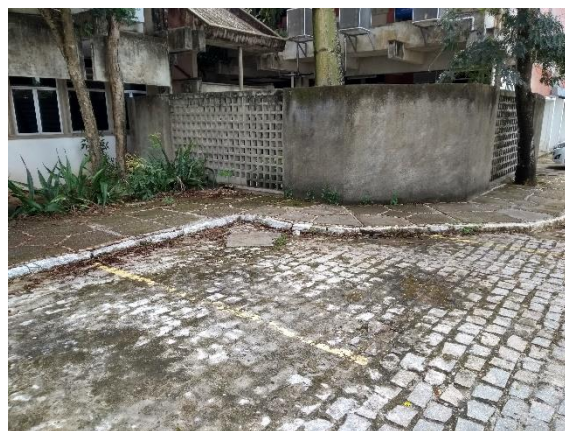
Figura 128: Calçada no entorno do CB
