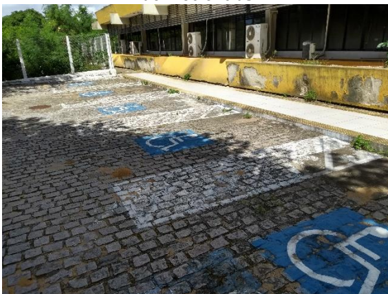
Figura 125: Estacionamento do anexo do Centro de Biociências
