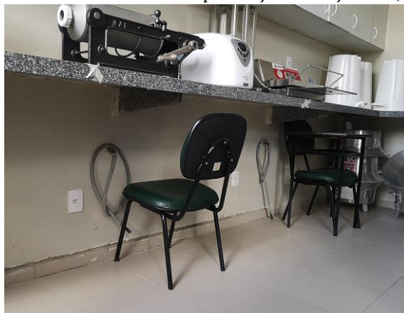
Figura 155: Pontos de Gás G.L.P na alvenaria; e Figura 156: Fogão com mangueira de borracha, sem a presença do botijão P13, no momento da visita técnica.
