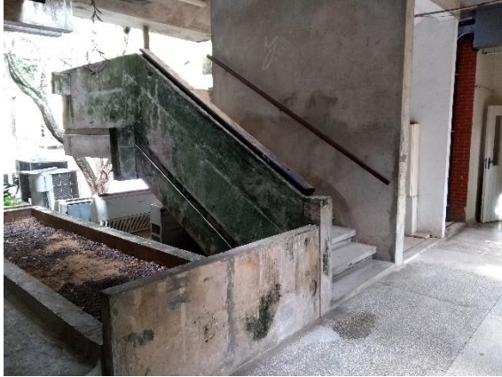
Figura 129: Escada interna no CB
