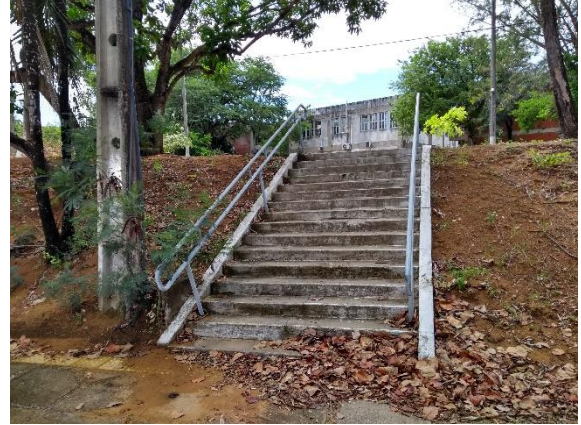
Figura 130: Escada externa no CB
