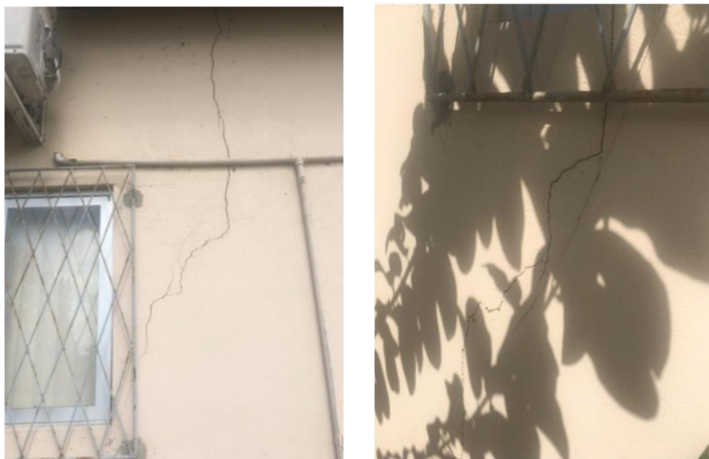
Figura 111: Mesma trinca da Figura 110 vista pelo lado externo da edificação e Trinca inclinada em elemento de alvenaria
