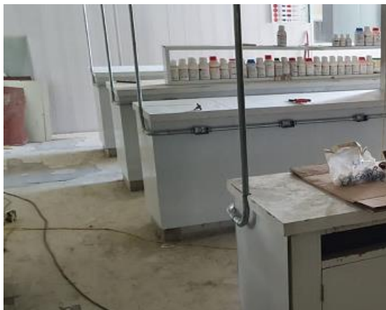
Figura 165: Momento da revisita: piso retirado e porcelanato aplicado sobre as bancadas e alvenarias, instalações elétricas novas bem como rede de gás G.L.P
