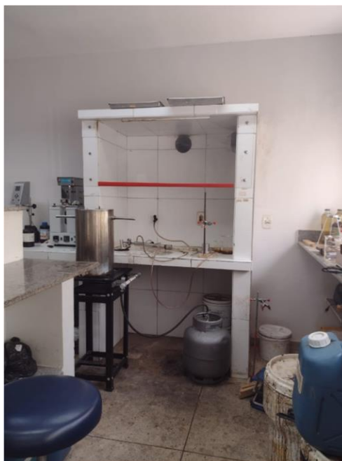
Figura 116: Cilindro de GLP dentro do laboratório na vista em 2021
