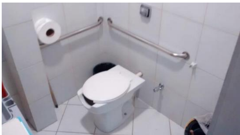
Figura 18: Exemplo de lavabo com barras, mas não correspondente aos padrões normatizados
