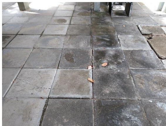
Figura 136: Detalhe do piso da circulação do NTI
