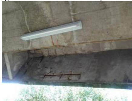
Figura 75: Prédio de Física Experimental
