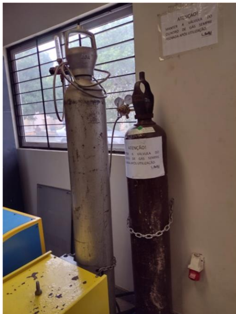
Figura 118: Cilindros de Gás Acetileno, Oxigênio, CO2 e Argônio dentro do laboratório na vista em 2021.
