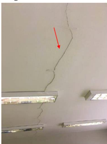
Figura 106: Forro no laboratório Tecnologia da Madeira na visita de 2017.
