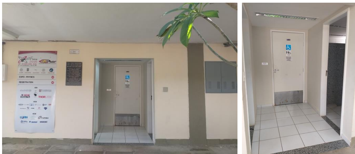
Figura 94: Vistas do acesso aos banheiros masculino, feminino e acessível.
