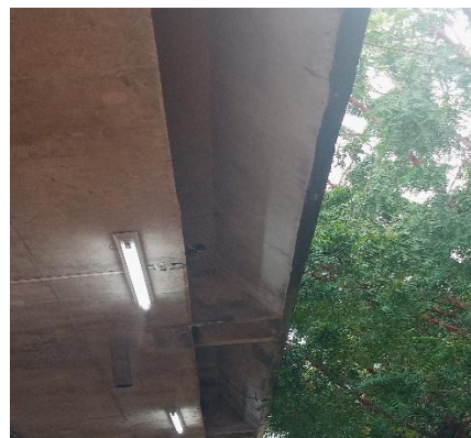
Figura 143: Cobertura do prédio de Física I
