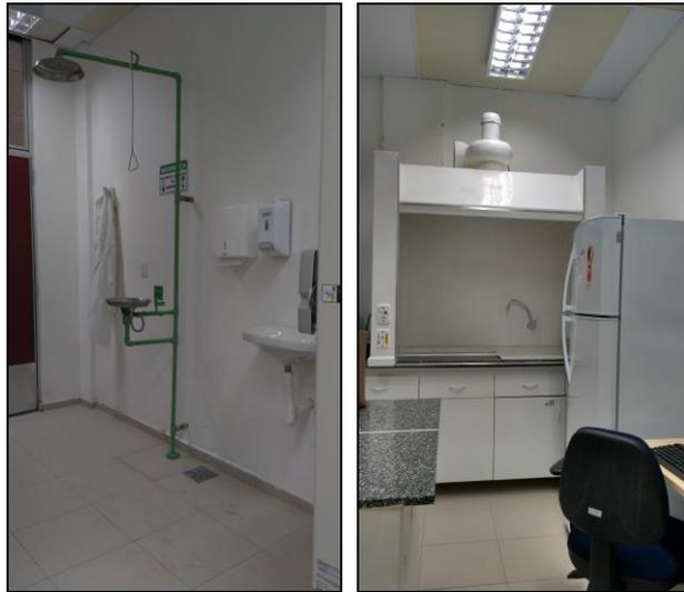
**Figura 9:** Chuveiro de emergência e capela
