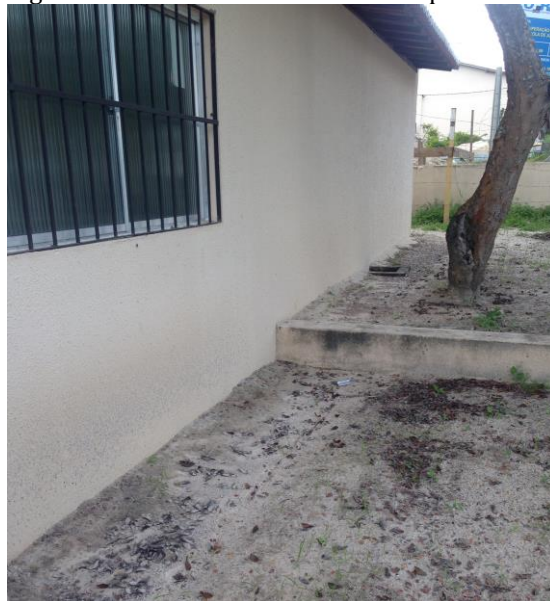
Figura 05: Terreno mais elevado na parte exterior
