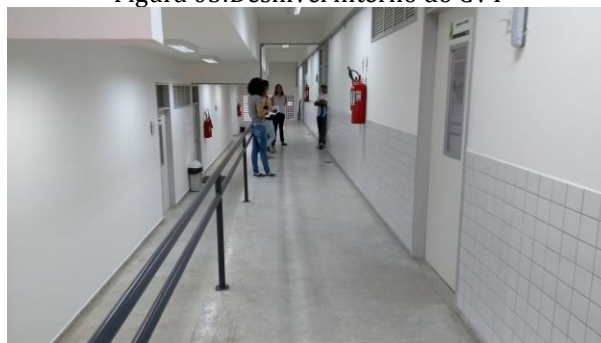
Figura 05: Desnível interno do CVT
