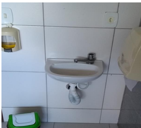
Figuras 07: O sifonamento do lavatório, não está com a altura correta (5 cm).
