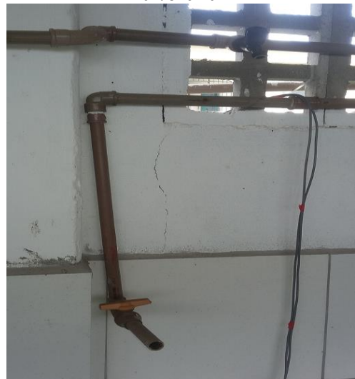
Figura 04: Fixar as tubulações de modo seguro na alvenaria
