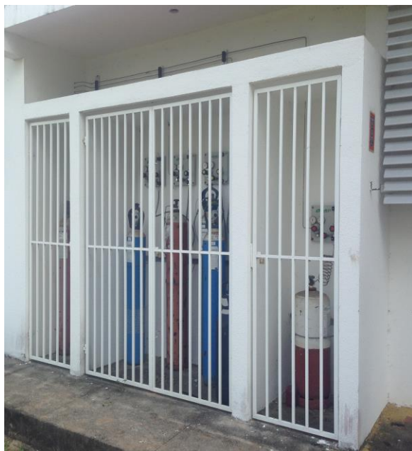
Figura 27: Central para gases especiais.
