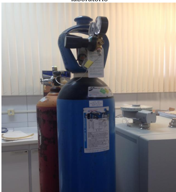
Figura 21: Gases medicinais no interior do laboratório
