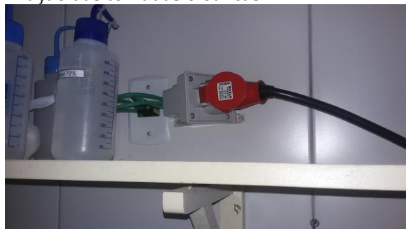
Figuras 08 e 09: Falta de padronização das tomadas elétricas
