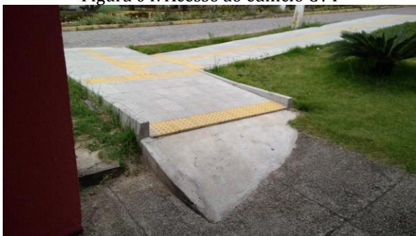
Figura 04: Acesso ao edifício CVT
