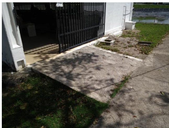
Figura 02: Acesso ao Laboratório de Peixes de Água Parada
