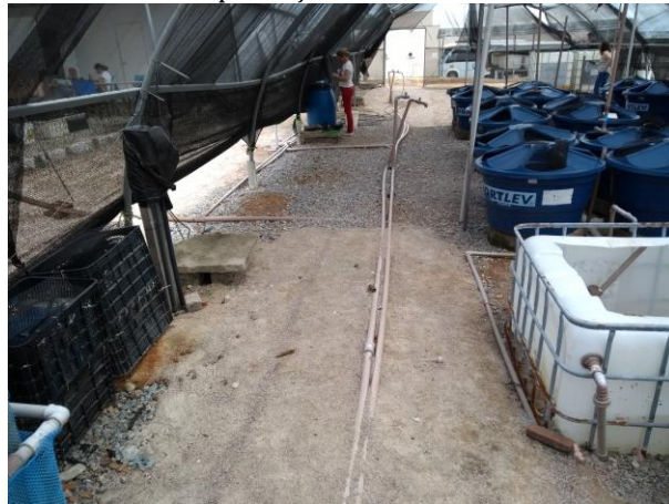
Figura 03: Interferência da tubulação na circulação do Laboratório de Larvicultura, Berçário e Reprodução de Camarão.
