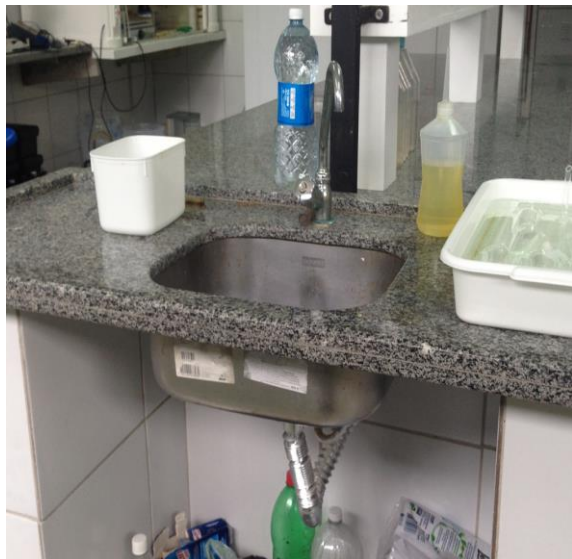
Figuras 08 e 09: Sifonamento inadequado para o esgoto das pias
