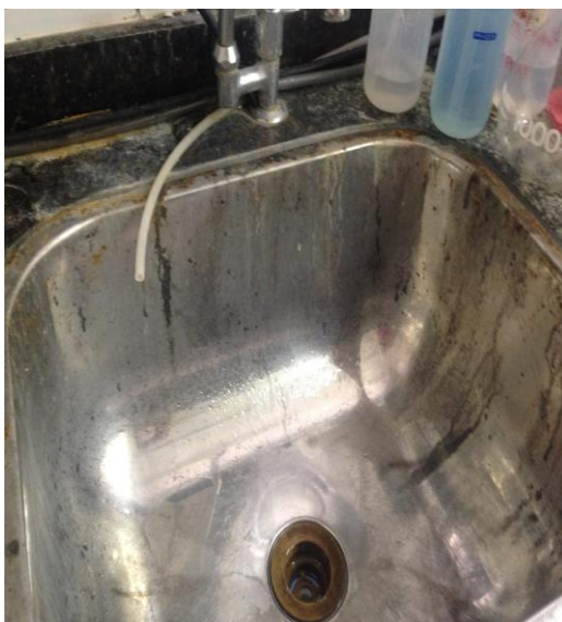
Figura 19: Cuba com bordas oxidadas.
