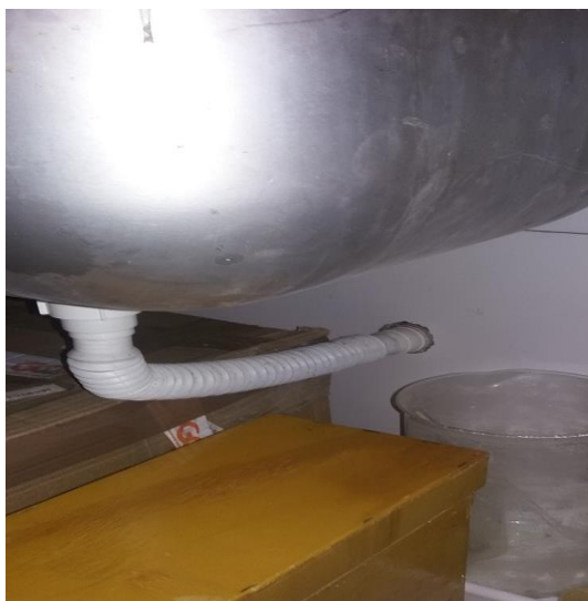
Figuras 07: O sifonamento do lavatório, não está com a altura correta (5 cm).
