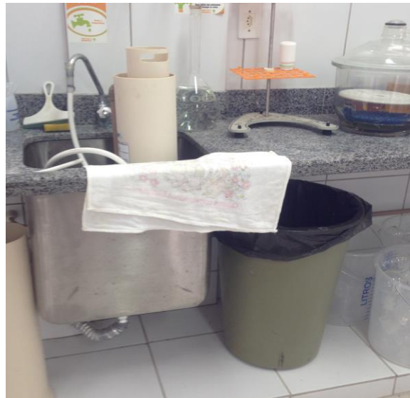
Figuras 08 e 09: Sifonamento inadequado para o esgoto das pias
