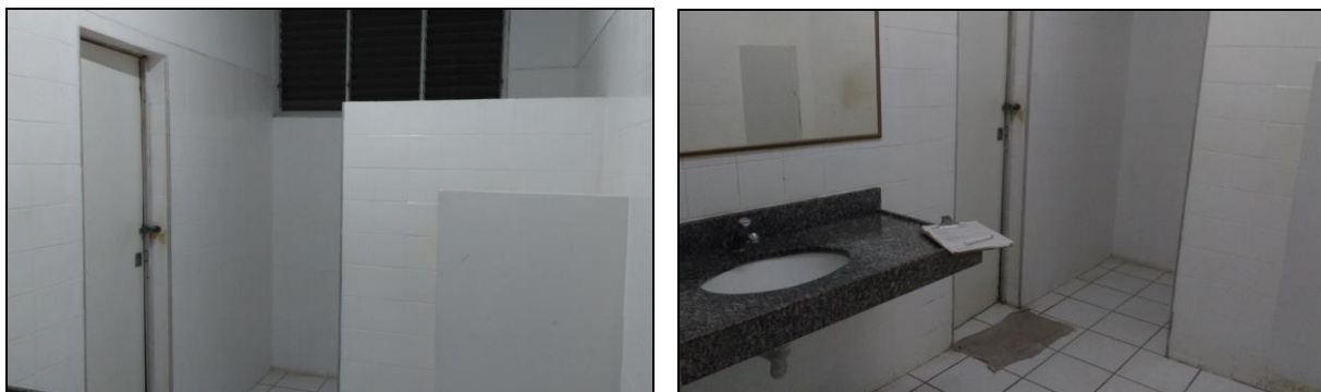
Figura 8: Vistas do banheiro
