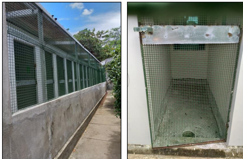
Figura 16: Vistas da área das gaiolas em reforma.
