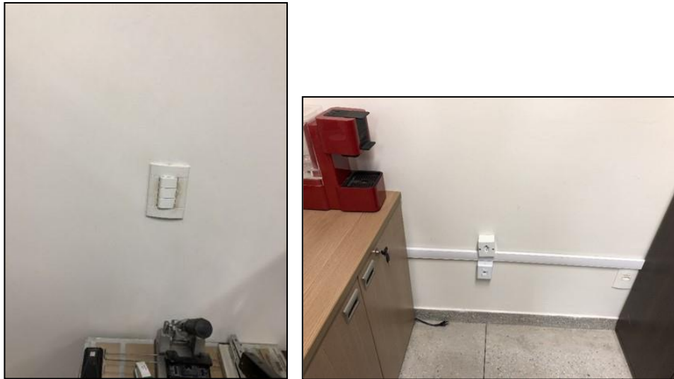
Figura 8: Interruptor e tomadas de sobrepor e de embutir
