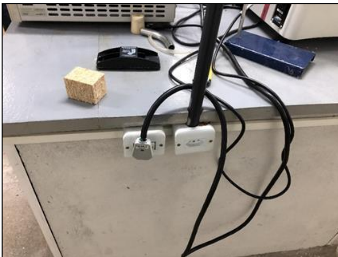
Figura 10: Interruptor sem identificação e tomada no novo padrão brasileiro
