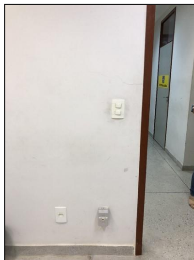
Figura 7: Interruptor e tomadas de sobrepor e de embutir.
