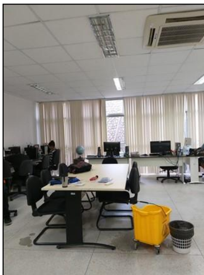
Figura 12: Balde recebendo a água de chuva que descia pelo cassete.
