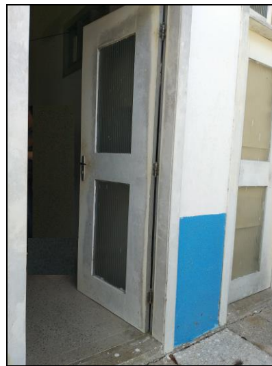
Figura 3: Porta de acesso do Laboratório
