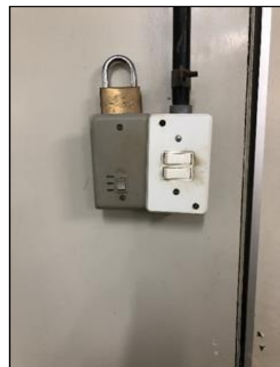
Figura 10: Interruptor sem identificação e tomada no novo padrão brasileiro
