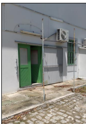
Figura 3: Porta de acesso do Laboratório
