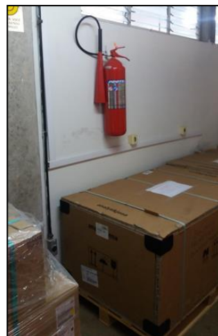
Figura 15: Cilindro de gás medicinal dentro do laboratório. Figura 16: Caixotes impedindo o acesso ao extintor
