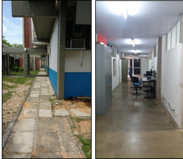
Figura 5: - Vista da circulação externa e interna de acesso ao Lab. Preparação de Amostras.
