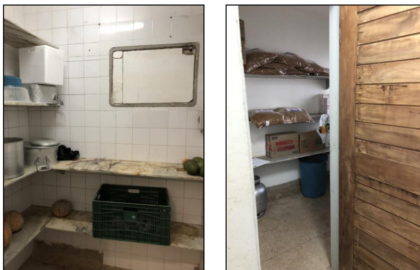
Figura 8: Vistas da antiga câmara fria e despensa
