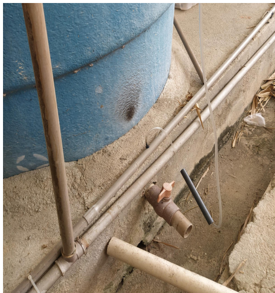
Figura 06: Fixar as tubulações de forma segura.
