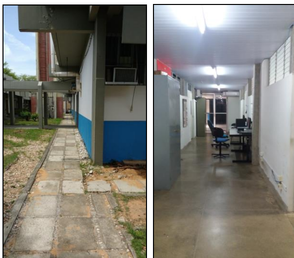
Figura 5: - Vista da circulação externa e interna de acesso ao Lab. Cromatografia Líquida e Gasosa.
