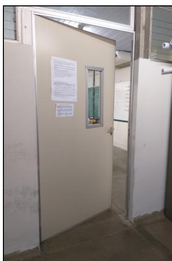
Figura 3: Porta de acesso do Laboratório
