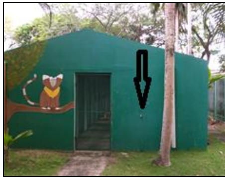
Figura 32: Torneiras na área externa com vazamento.
