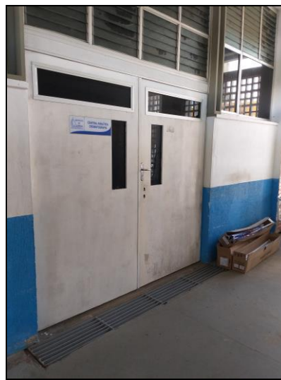
Figura 3: Porta de acesso do Laboratório
