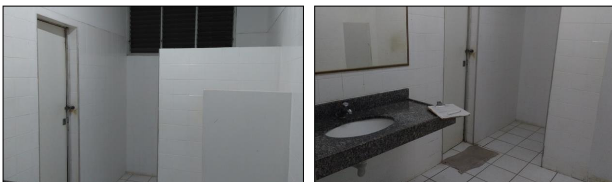
Figura 11: Vistas do banheiro
