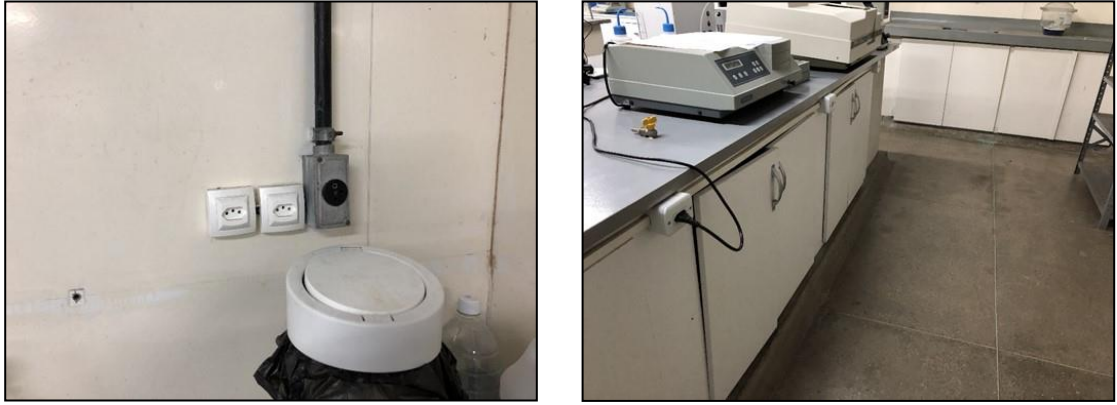
Figura 9: Tomadas no padrão antigo junto com as novas.
