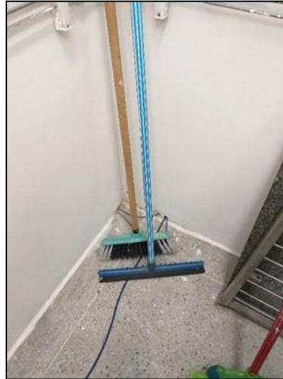
Figura 15: Cabeamento estruturado exposto sem a utilização de dutos.
