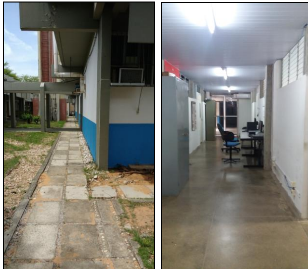
Figura 5: - Vista da circulação externa e interna de acesso ao Lab. Análise Térmica.
