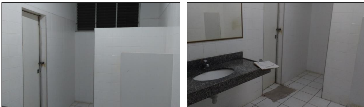
Figura 9: Vistas do banheiro
