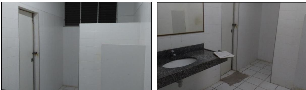
Figura 8: Vistas do banheiro
