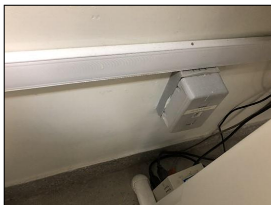
Figura 11: Pontos de lógica não identificados.
