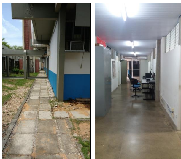
Figura 5: - Vista da circulação externa e interna de acesso ao Lab. Espectroscopia UV-VIS.
