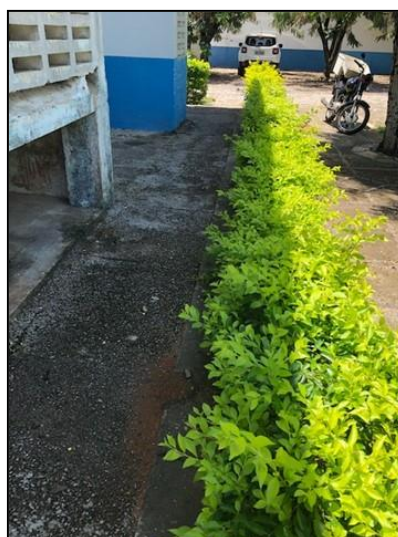
Figura 21: Presença de jardim localizado na fachada frontal e que pode ter contribuído para percolação de finos do solo.
