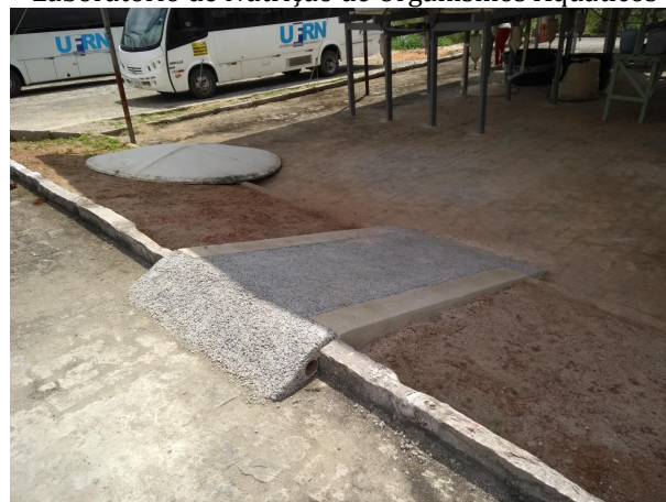
Figura 03: Rampa inadequada no entorno do Laboratório de Nutrição de Organismos Aquáticos
