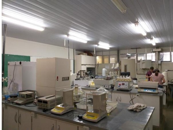
Figura 11: - Luminárias do laboratório
