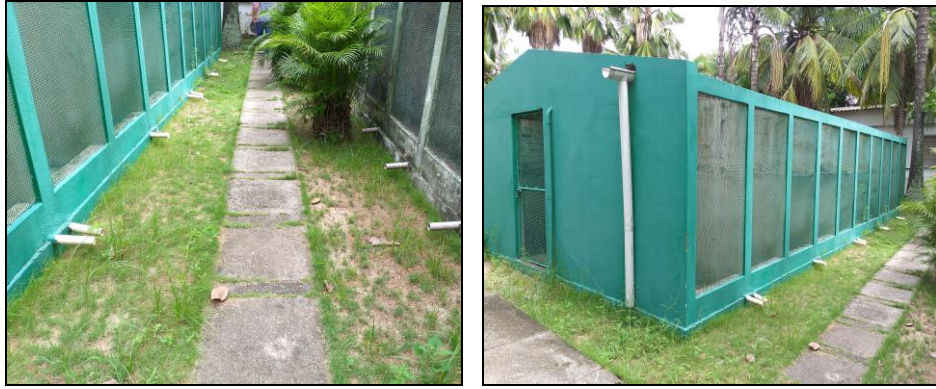
Figura 31: Tubulação saindo de cada gaiola para descarga do esgoto gerado dentro da mesma.
