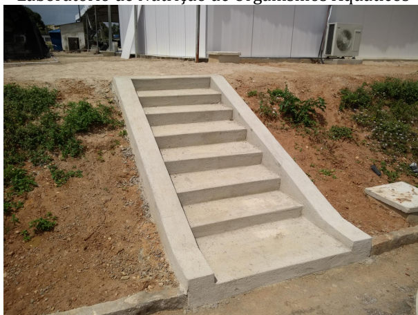
Figura 02: Escada inadequada no entorno do Laboratório de Nutrição de Organismos Aquáticos
