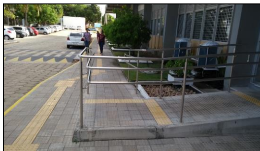
Figura 5: – Vista da circulação externa de acesso ao Lab. Informática.
