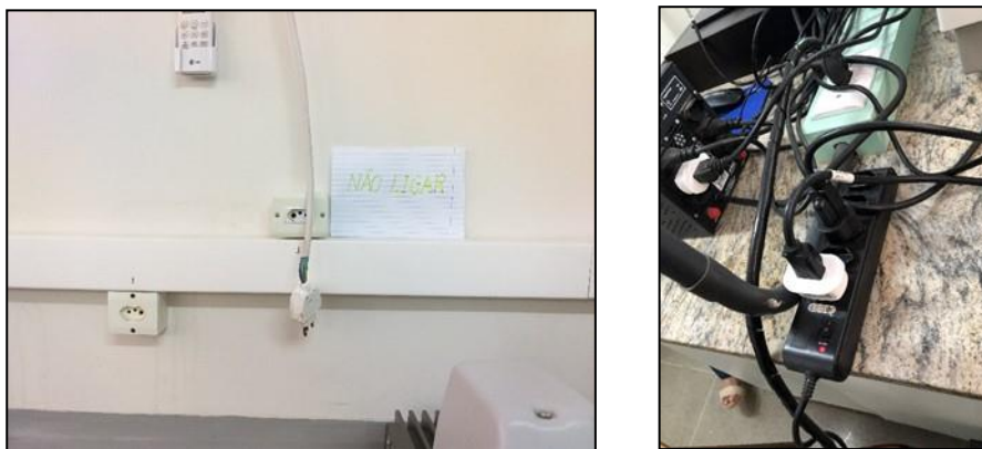
Figura 9: Tomadas no novo padrão e filtro de linha
